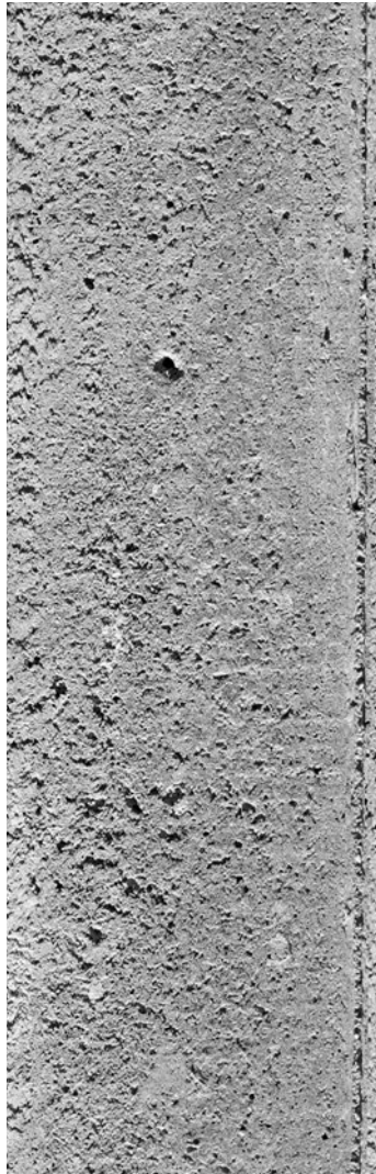
Muros hormigón armado
